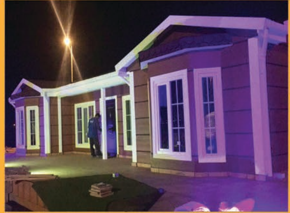
مبنى المكاتب في المعرض
