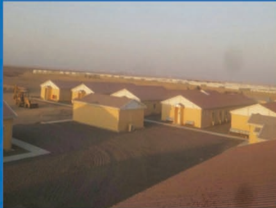
انشاء سكن عماله في مدينه وعد الشمال بطريف
